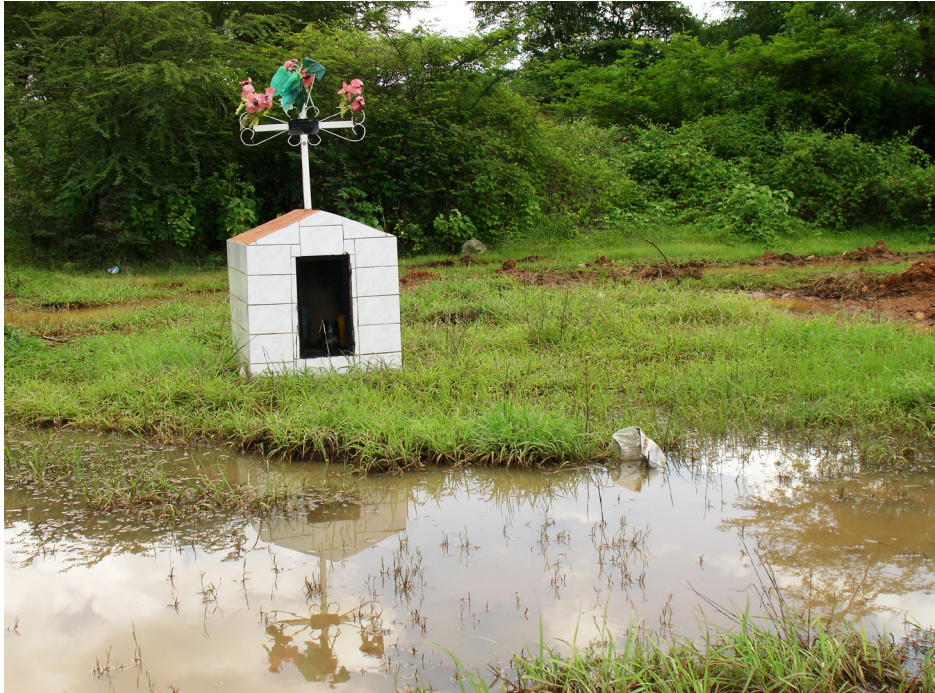
Capillita coronada con cruz de hierro en cuya construcción se utilizó cerámica y ha sido adornada con flores de plástico. Carretera Lara –Zulia. Junio 2006.
